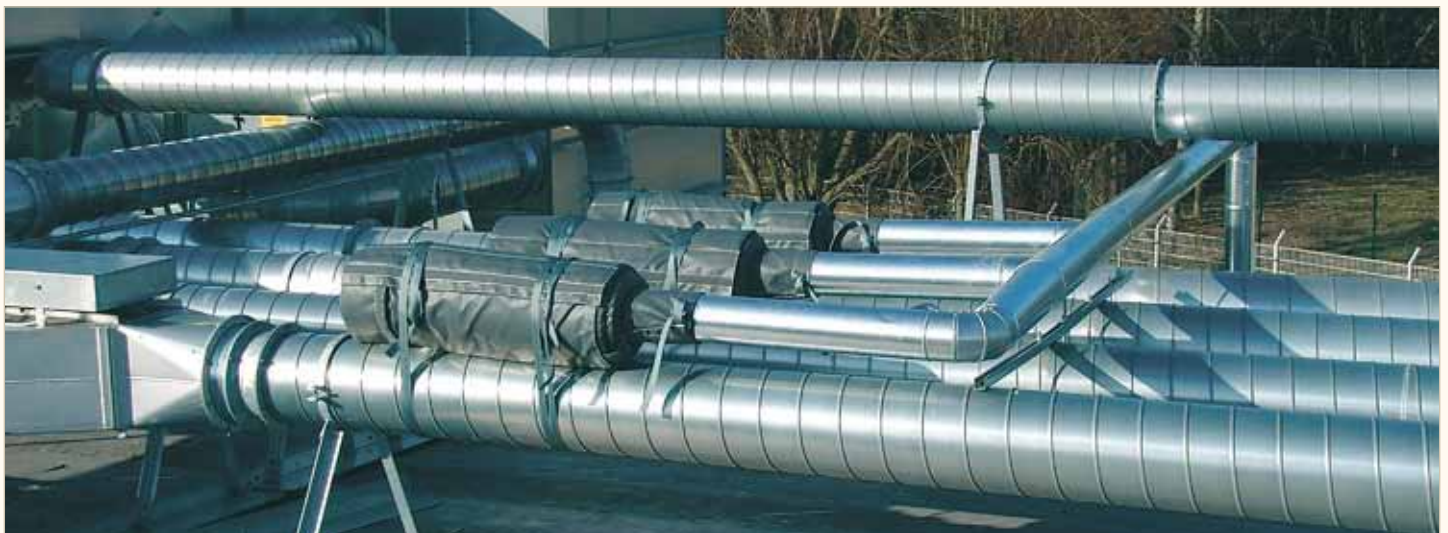
Защита от мороза с помощью изолирующих кожухов
