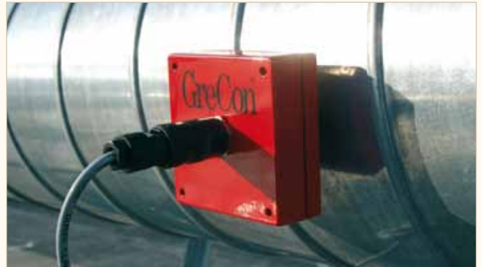
Смонтированный искросигнальный датчик
